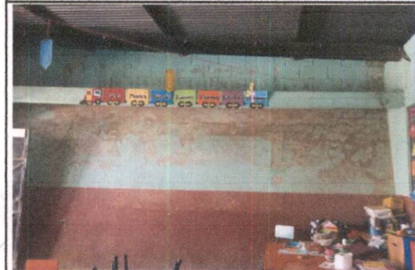
Foto 4: MEJORAMIENTO DE PARED INTERIOR DEL AULA DE PARVULOS 2.
