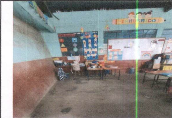
MEJORAMIENTO DE PISO EN DOS AULAS DE PREPRIMARIA
